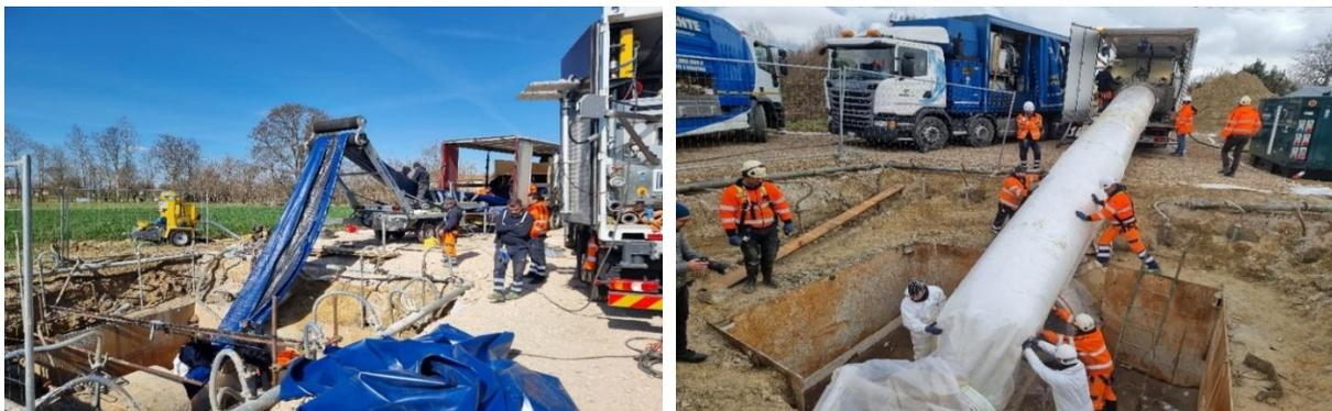
Figura 3: a sx l'inserimento della guaina polimerizzata tramite raggi UV, a dx l'inversione del liner ad aria con riscaldamento a vapore.
